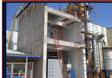
Montaje y fabricación
